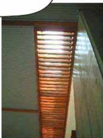
メインホール上部(室内側)
