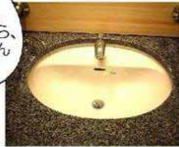
洗面器 自動水栓
