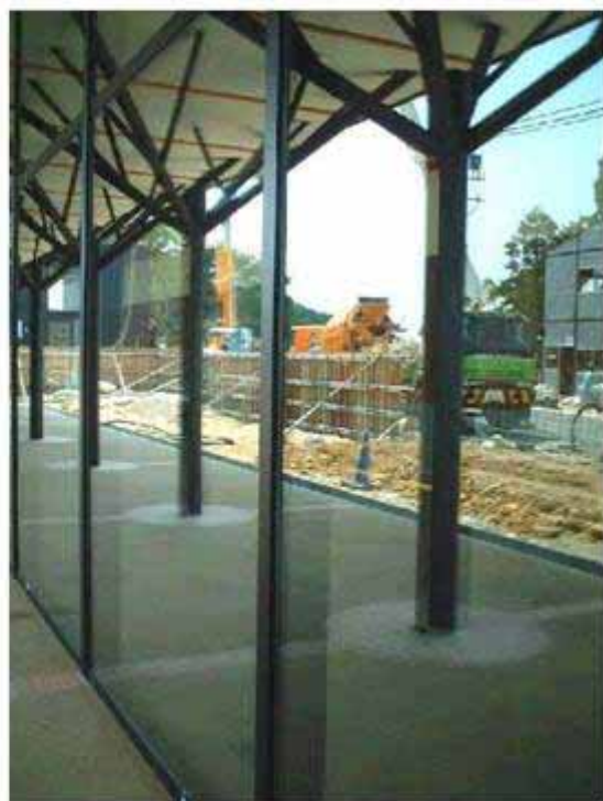
ロビーの屋外側
