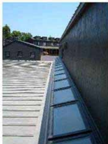
メインホール上部(室外側)
