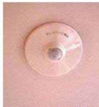
昼光センサー(天井に設置)
